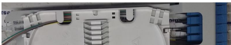
Fot.7 – przeprowadzenie optyki na kasetę, w celu przygotowania do spawania
