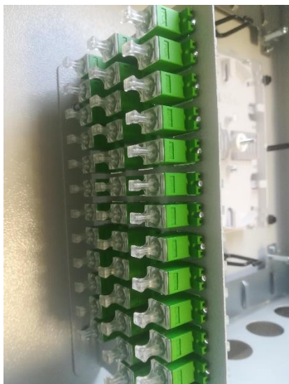
Fot.1 Pole liniowe z adapterami typu SC/APC.
