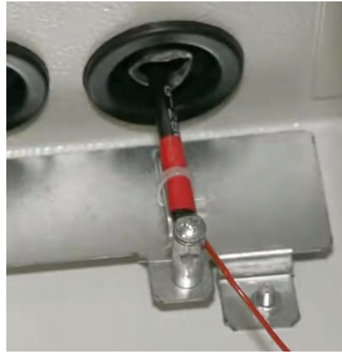
Fot.4 Zamocowany kabel liniowy
