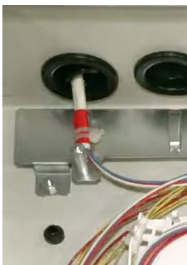
Fot.9 Mocowanie kabla łatwego dostępu.
