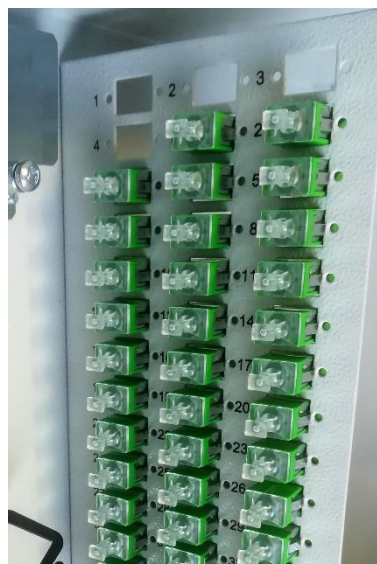
Fot.2 Pole abonenckie z adapterami typu SC/APC.
