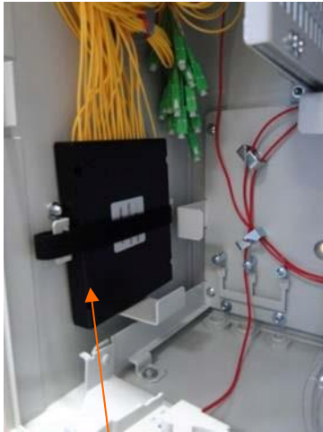
Montaż sprzęgacza w obudowie typu BlackBox
