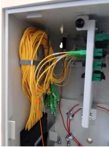
Uwinięcie zbędnej długości wyprowadzeń
