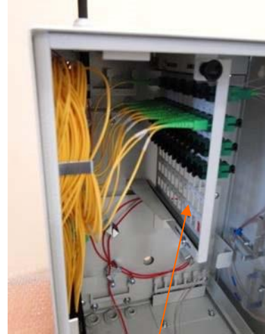
Wpięcie wyprowadzeń sprzęgacza w pole komutacyjne
