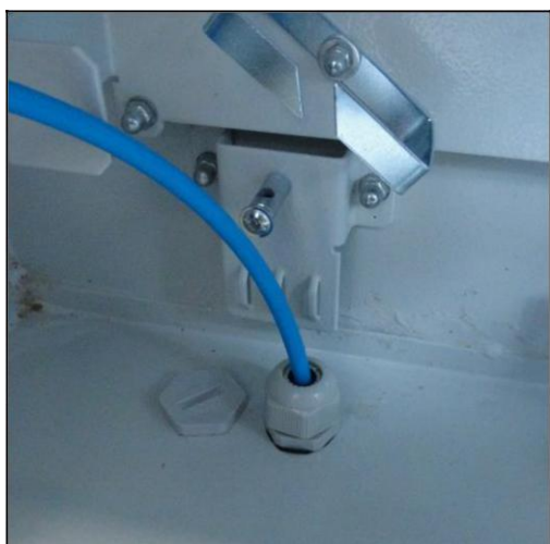
Fot.7 Wprowadzenie mikrokabla bez osłony
