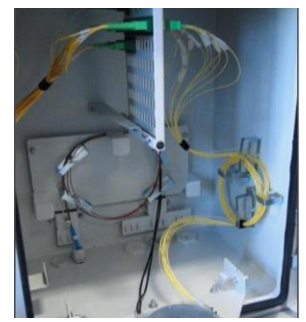
Fot. 17 i 18 doprowadzenie tuby mikrokabla w osłonie do kasety spawów oraz ogólna organizacja pigtaili
