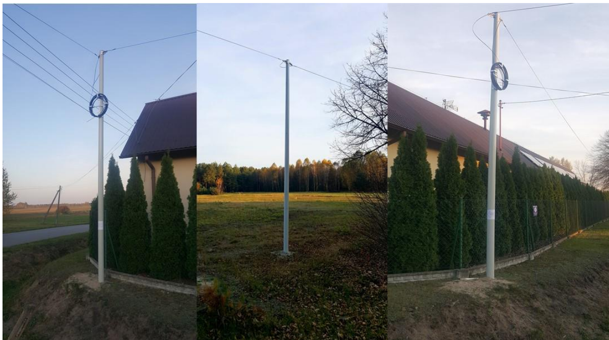
Zdjęcie 2. Słupy kompozytowe po zakończeniu montażu.
