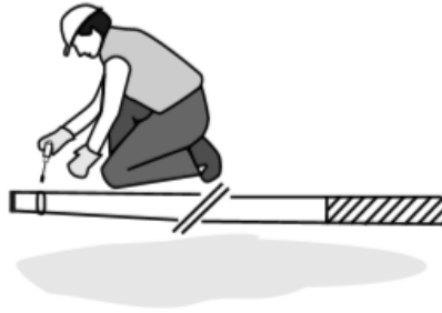
Rys.3. Przygotowanie słupa- uzbrojenie wierzchołka słupa w oprzęt za pomocą taśmy stalowej przed montażem w wykopie/odwiercie.
