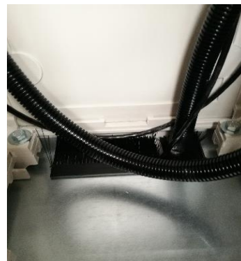
Fot.8a - wprowadzenie peszli przez przepust
