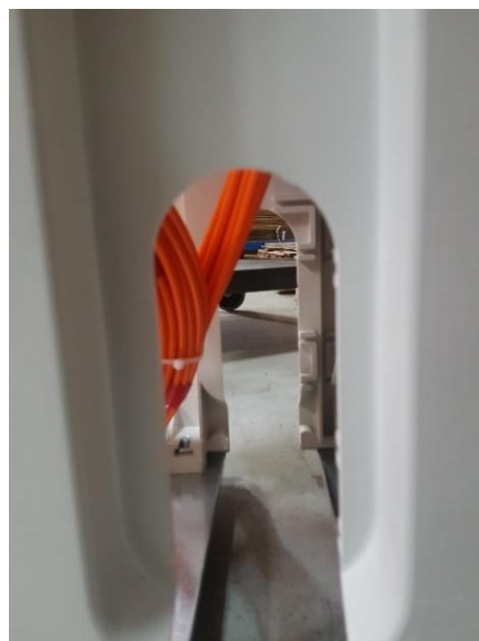
Fot.4 - Dodatkowe wycięcia na rury (fi 50 mm) – praca wykonawcy
