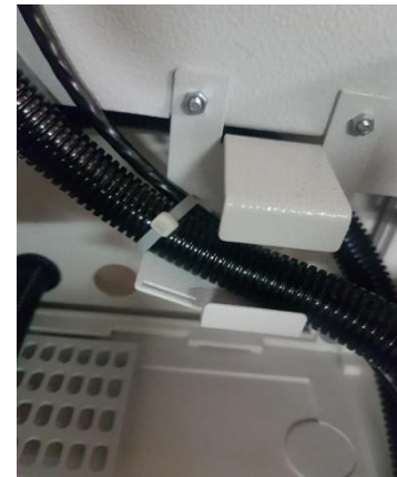
Fot.10 - Peszel z mikrokaablami przymocowany do uchwyty wejściowego w module wewnętrznym
