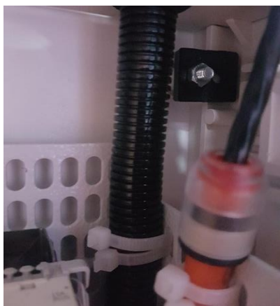
Fot.9 - Przymocowany peszel i mikrorurka, uszczelnienie pakietu mikrorurek (FP-UWD)
