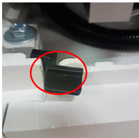
Fot.5 – Rygiel do otwarcia dolnej komory kablowej
