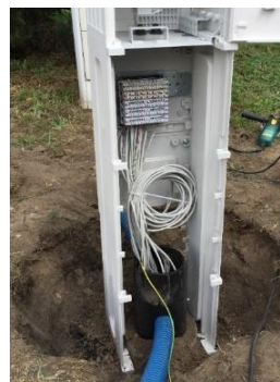
Fot.2 Szafka SUS-PH ustawiana w grunt w miejsce poprzedniego słupka miedzianego.
