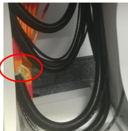
Fot.6 - Wprowadzone tuby kabli DAC w peszle
