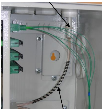
Zabezpieczenie włókien kabla stacyjnego węzłem spiralnym
