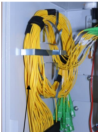
Uwinięcie nadmiaru długości wyprowadzeń sprzęgacza
