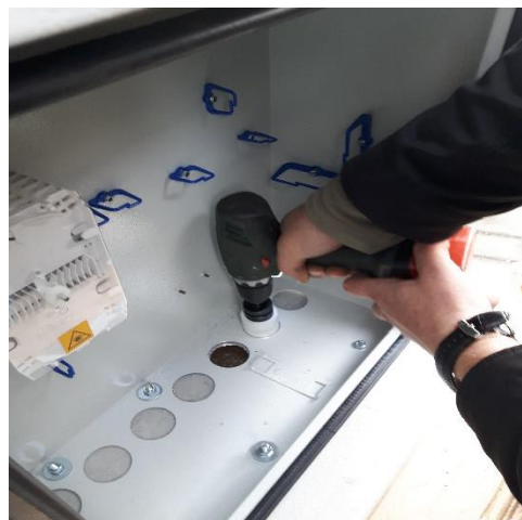
Fot.5 Wywiercenie przepustów pod kable optyczne.
