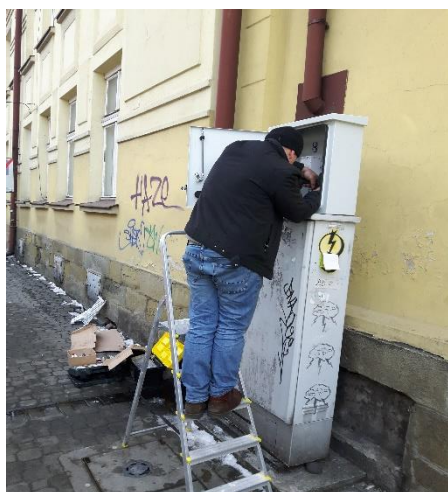
Fot.1 Widok montowanej PSB-NH na szafie typu CU.
