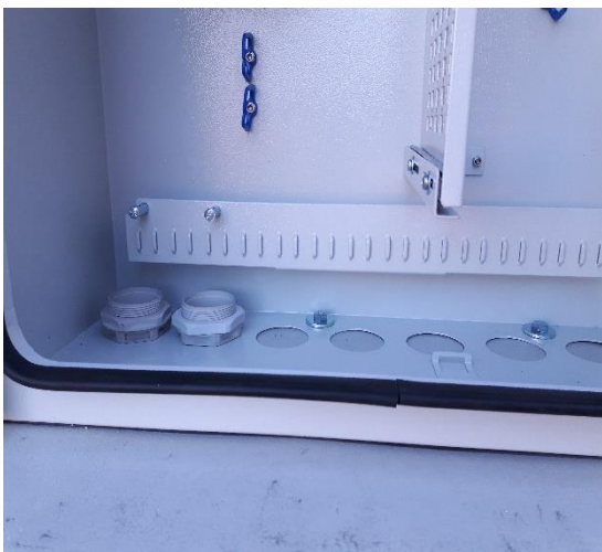
Fot.4 Zamontowane śruby mocujące obudowę.
