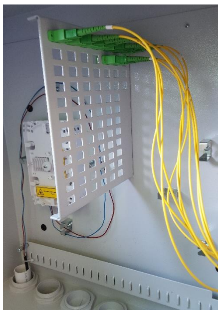
Fot.7 Pole liniowe z adapterami typu SC/APC.
