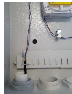
Fot.4 Mocowanie kabla światłowodowej wprowadzonego do przełącznicy w rurze wewn.
