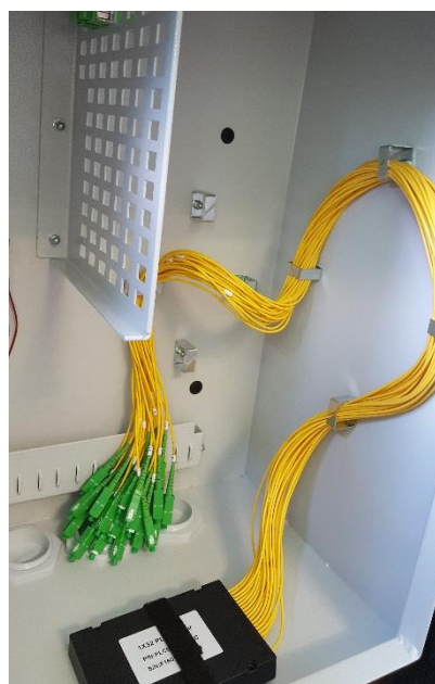
Fot.8 Zamontowany sprzęgacz optyczny.
